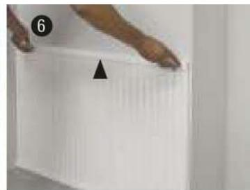
Provide expansion gap at ratio 1mm/m (3/84" per 39 3/8") | Voorzie een uitzettingsvoeg van 1mm/meter | Prévoir un joint de dilatation de 1mm/mètre | Sehen Sie eine Dehnungsfuge von 1 mm/Meter | Prevea una junta de dilatación de 1 mm/metro | Оставьте компенсационный отступ в 1 миллиметр
