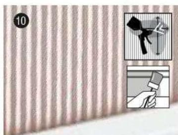
Use DecoFiller to smooth out the visible joints and all vertical seams | Gebruik DecoFiller om de zichtbare voegen en alle verticale nadelen glad te strijken | Utilisez DecoFiller pour lisser les joints visibles et tous les joints verticaux | Verwenden Sie DecoFiller, um die sichtbaren Fugen und alle vertikalen Nähte zu glätten | Utiliza DecoFiller para alisar las juntas visibles y todas las costuras verticales | Используйте DecoFiller для выравнивания видимых стыков и всех вертикальных швов
