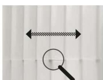
Apply DecoFix Extra to the short seam of the panel as close to the wallside as possible | Breng DecoFix Extra aan op korte zijde van paneel, zo dicht mogelijk naar wandzijde toe | Appliquez DecoFix Extra sur le côté court du panneau | DecoFix Extra auf die kurze Seite der Platte auftragen | Aplique DecoFix Extra en el lado corto del panel | Нанесите DecoFix Extra на короткую сторону панели
